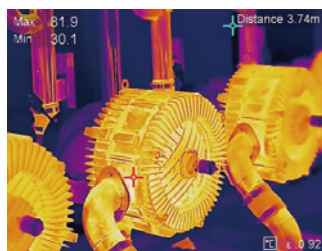
機械設備検査
