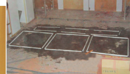
店舗施工中風景
